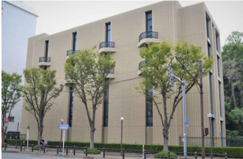
図2 大濠変電所の外観 8)
